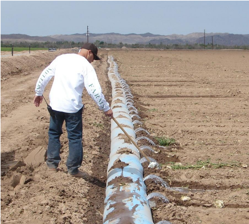
Agujeros En Politubo con Herramienta Multi- diametros
